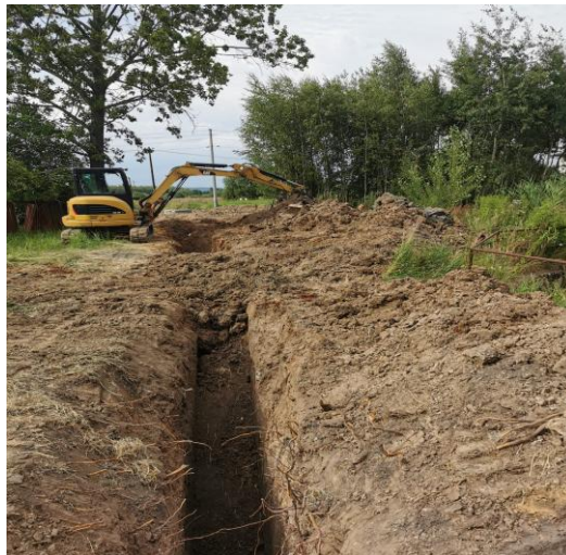
Budowa kanalizacji w Brzeźnicy
