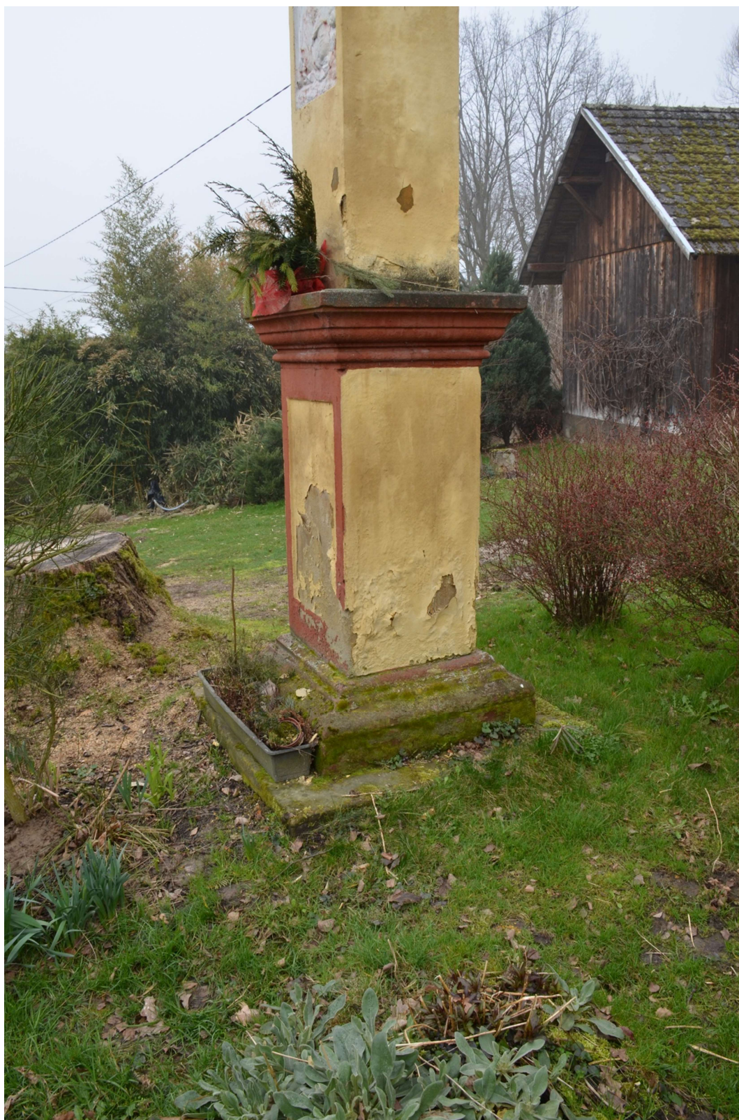
Fot. nr 2. Kamienna kapliczka Chrystusa Króla Cierniem Koronowanego. Widoczne na fotografii: cokół kapliczki przestłonięty nawarstwieniami mikrobiologicznymi, nawarstwienia na powierzchni kamienia.
