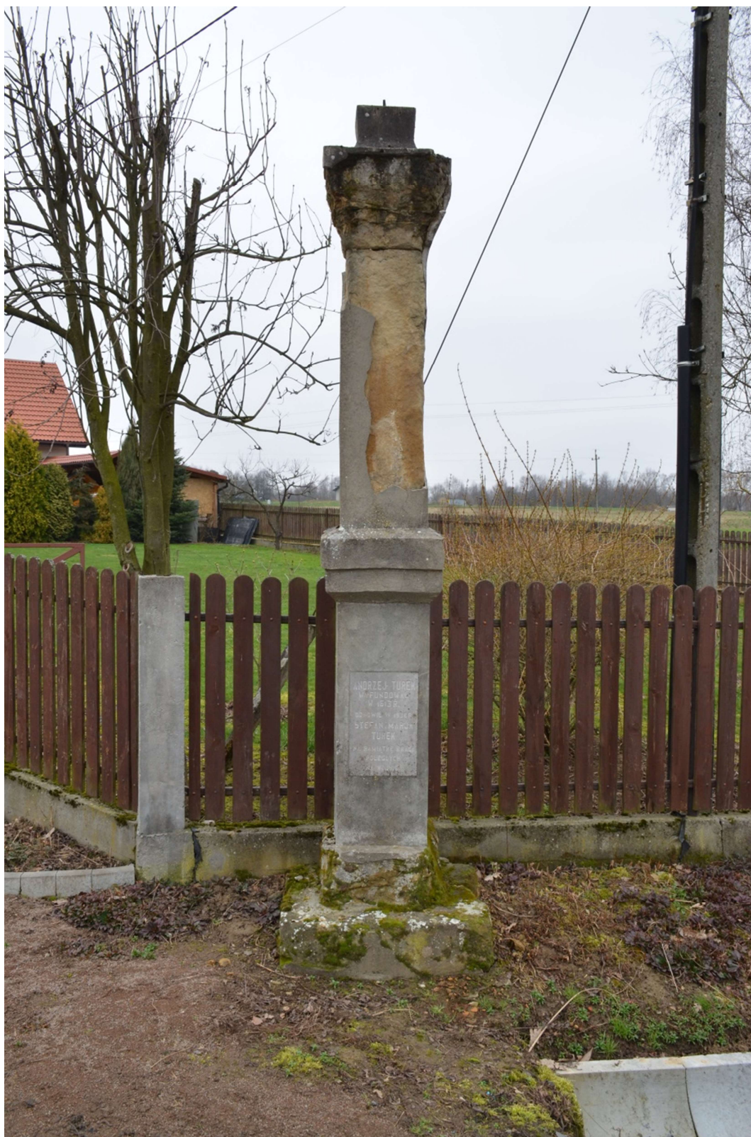
Fot. nr 2. Kamienna kapliczka Świętego Józefa w Marcyporębie. Widoczne na fotografii: Znacząca utrata substancji zabytku, obszerne uzupełnienia formy rzeźbiarskiej masą betonową, brak figury wieńczącej kapliczkę.
