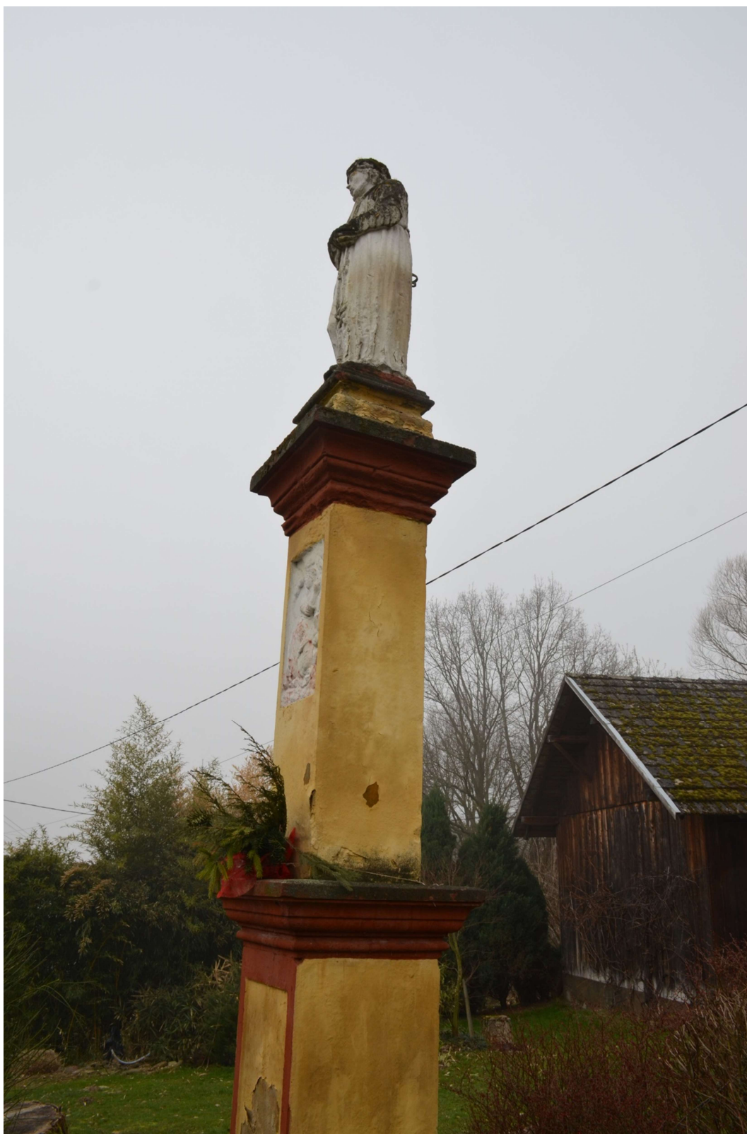
Fot. nr 1. Kamienna kapliczka Chrystusa Króla Cierniem Koronowanego. Widoczne na fotografii: liczne nawarstwienia na powierzchni kamienia, przemalowania, ubytki i zbrudzenia kamienia.
