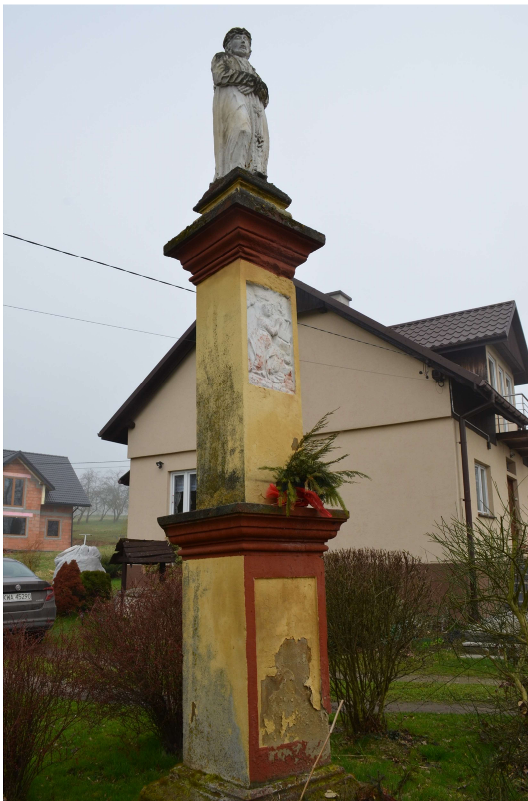
Fot. nr 3. Kamienna kapliczka Chrystusa Króla Cierniem Koronowanego. Widoczne na fotografii: liczne nawarstwienia na powierzchni kamienia, przemalowania, ubytki i zbrudzenia kamienia.
