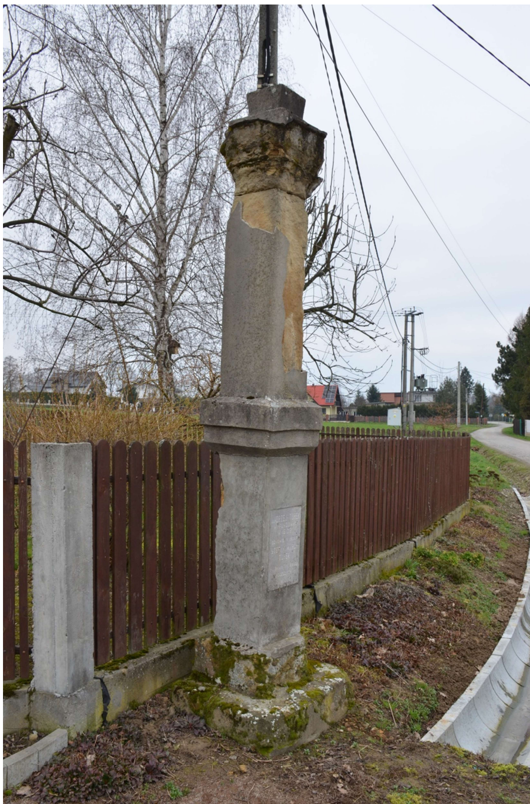
Fot. nr 3. Kamienna kapliczka Świętego Józefa w Marcyporębie. Widoczne na fotografii: Znacząca utrata substancji zabytku, obszerne uzupełnienia formy rzeźbiarskiej masą betonową, brak figury wieńczącej kapliczkę, przechył całej kompozycji kapliczki.
