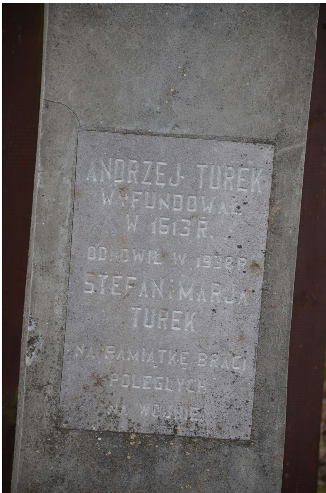
Fot. nr 4. Kamienna kapliczka Świętego Józefa w Marcyporębie. Widoczne na fotografii: degradacja powierzchni tablicy fundacyjnej, zabrudzenia i nawarstwienia powierzchniowe.
