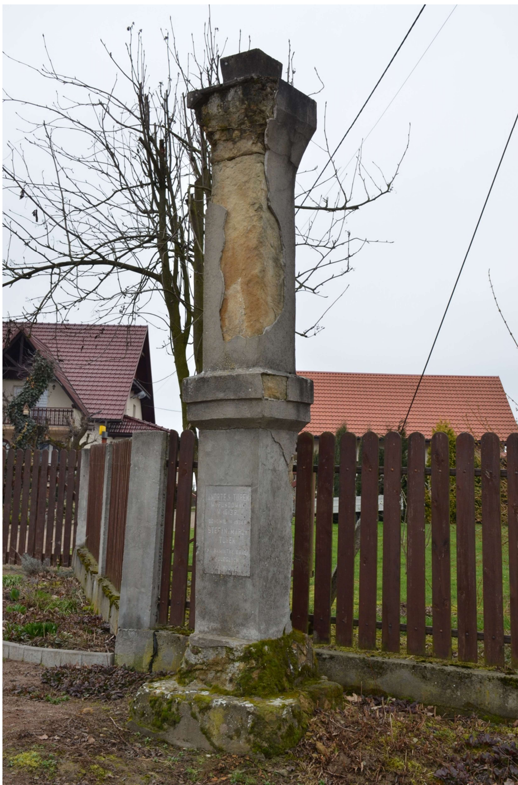
Fot. nr 1. Kamienna kapliczka Świętego Józefa w Marcyporębie. Widoczne na fotografii: Znacząca utrata substancji zabytku, obszerne uzupełnienia formy rzeźbiarskiej masą betonową, brak figury wieńczącej kapliczkę.
