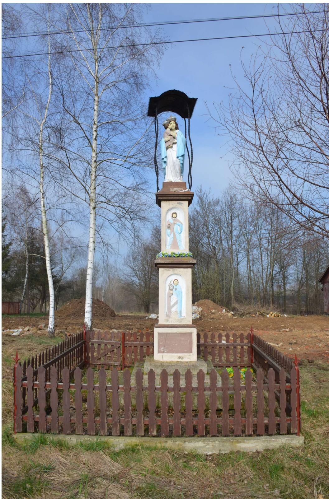
Fot. nr 1. Kamienna kapliczka Matki Boskiej Cudownej Kalwaryjskiej w Kopytówce. Widoczne na fotografii: liczne nawarstwienia na powierzchni kamienia, przemalowania, uzupełnienia, na powierzchni kamienia, drewniane ogrodzenie wokół pomnika.
