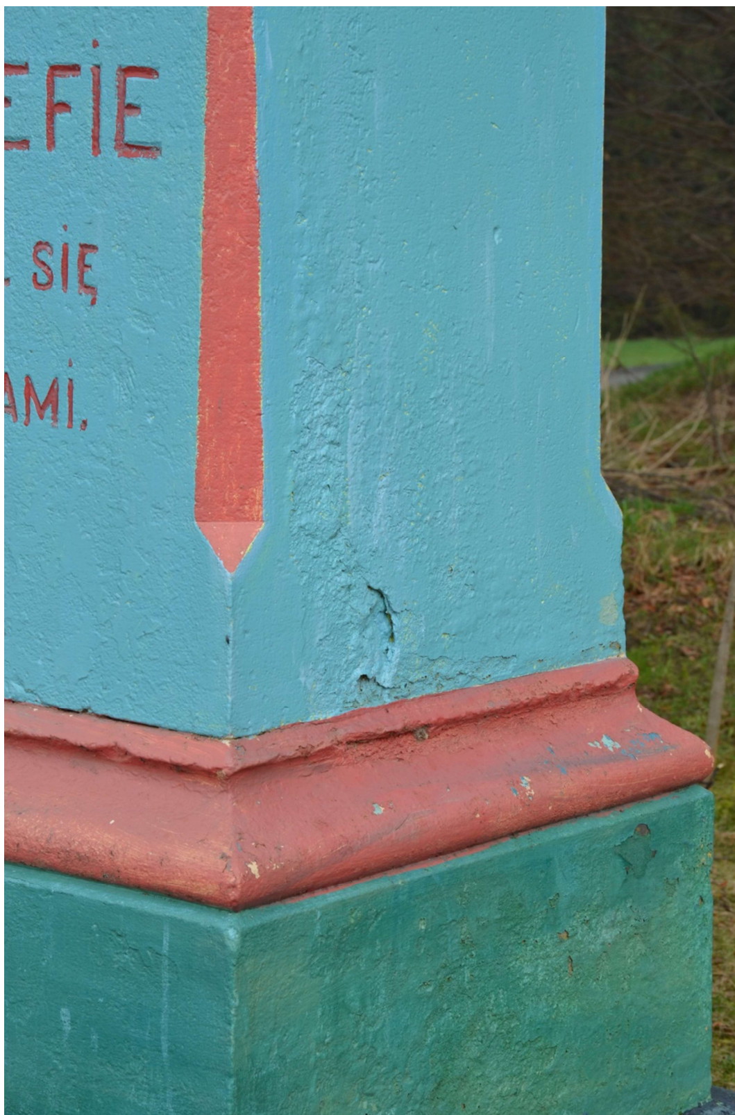
Fot. nr 4. Kamienna kapliczka Św. Józefa z Dzieciątkiem w Kopytówce. Widoczne na fotografii: obszerne przemalowania powierzchni kamienia, zabrudzenia i namarstwienia mikrobiologiczne na powierzchni cokółu.
