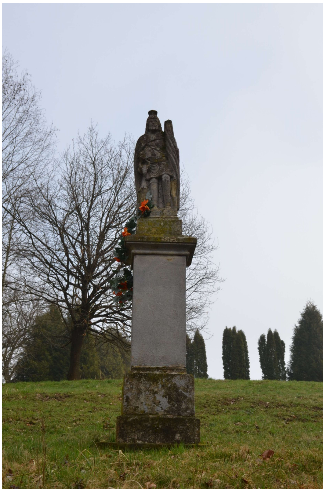
Fot. nr 1. Kamienna kapliczka Św. Floriana w Marcyporębie. Widoczne na fotografii: liczne nawarstwienia na powierzchni kamienia, obrzutka tynkarska, przeomalowania, mchy, glony i mikroorganizmy pokrywające cokół kapliczki.
