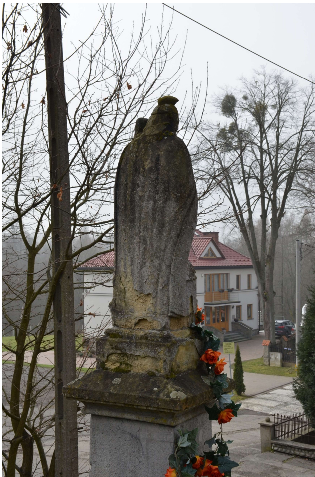
Fot. nr 3. Kamienna kapliczka Św. Floriana w Marcyporębie. Widoczne na fotografii: liczne nawarstwienia na powierzchni kamienia, obrzutka tynkarska, dezintegracja strukturalna, ubytki formy rzeźbiarskiej, przemalowania, mchy, glony i mikroorganizmy.
