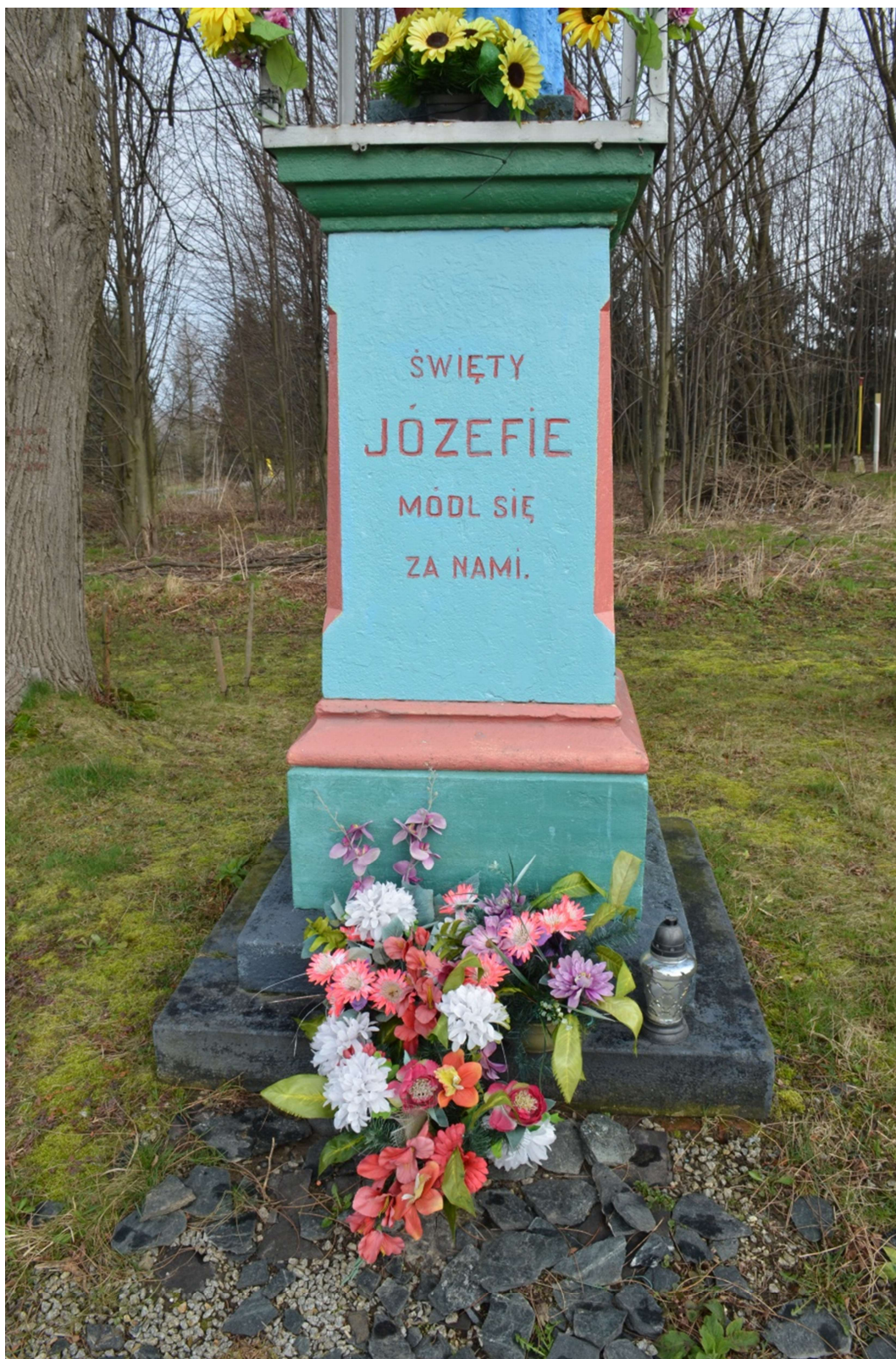
Fot. nr 3. Kamienna kapliczka Św. Józefa z Dzieciątkiem w Kopytówce. Widoczne na fotografii: obszerne przemalowania powierzchni kamienia, zabrudzenia i namarstwienia mikrobiologiczne na powierzchni cokółu.
